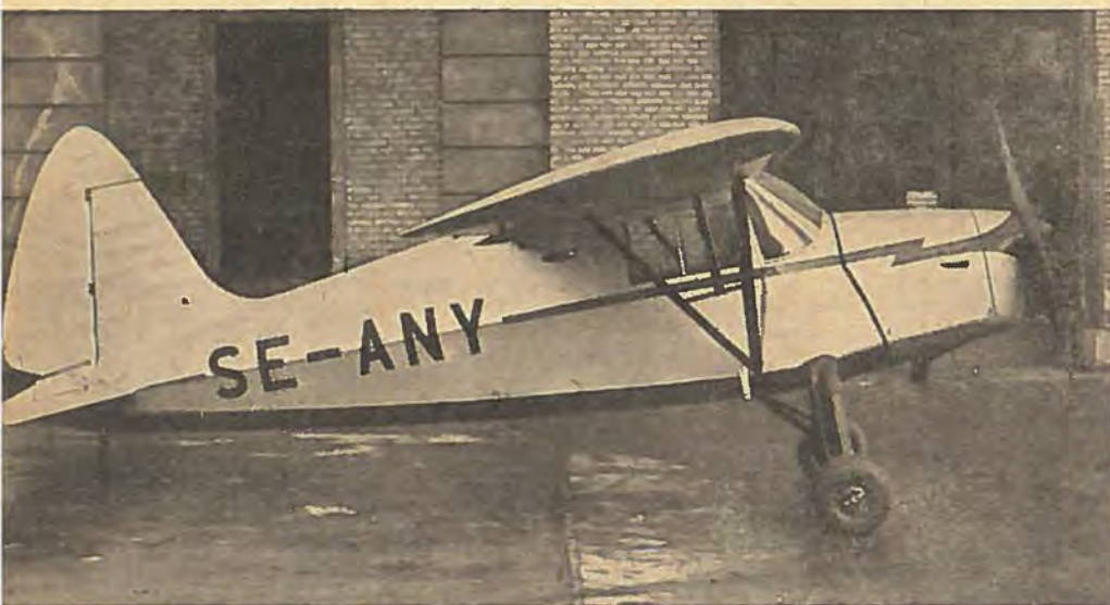
Fremtidens danske Privatmaskine: KZ III, et højtvinget Monoplan med 165 Kilometer Marchhastighed, to-sædet side by side og i Stand til at starte paa 35 Meter. Den kan lande paa 30 Meter.
